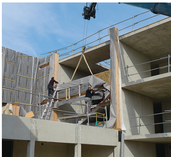
▲ Les locaux de la CC du Val de Drôme en construction
